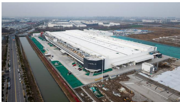
航拍特斯拉上海储能超级工厂（视觉中国）
