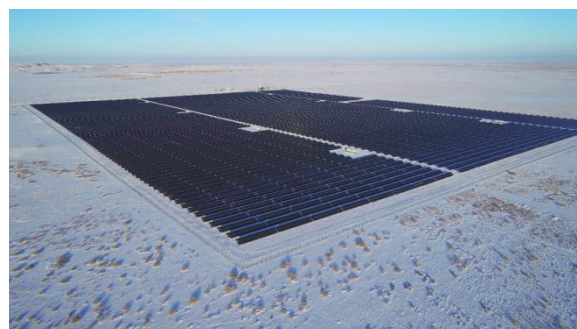
位于哈萨克斯坦的巴尔喀什光伏电站，选用隆基高性能 Hi-MO 组件，为当地高耗能行业降碳提供帮助
