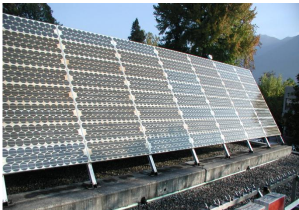
图3 已经运行了近40年的光伏组件
